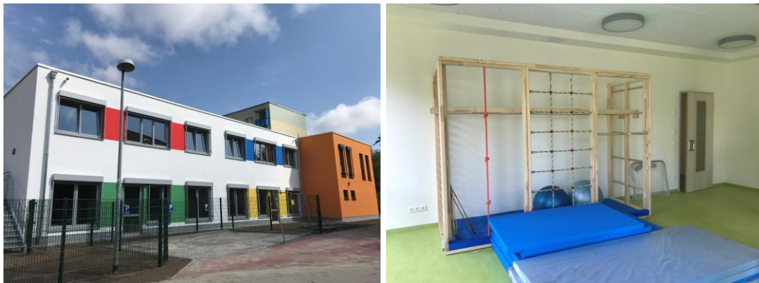
Abbildung 33: Erweiterungsbau der Kita Grünhufe, Stralsund
