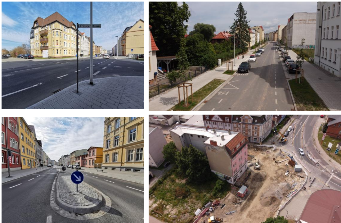
Abbildung 29: Neugestaltung Tribseer Damm, Stralsund
