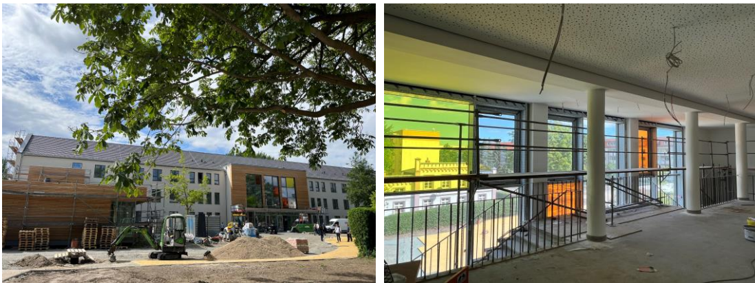
Abbildung 36: Sanierung des Schulgebäudes und der Außenanlagen der Grundschule Juri Gagarin in Stralsund
